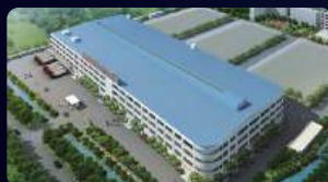
2-й завод в Чжуншане
