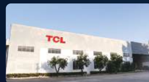
Завод по производству инверторных контроллеров
